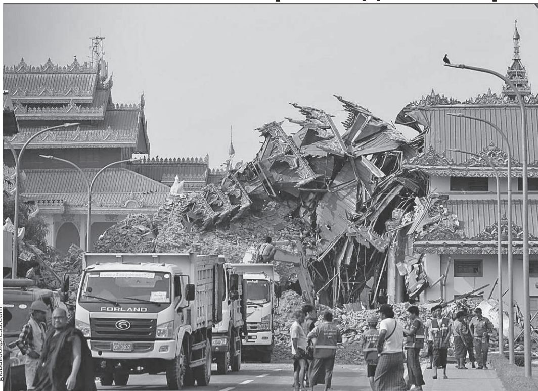
Основной удар стихии принял на себя город Мандалай в Мьянме. Сотни домов в нем оказались разрушены или повреждены.
