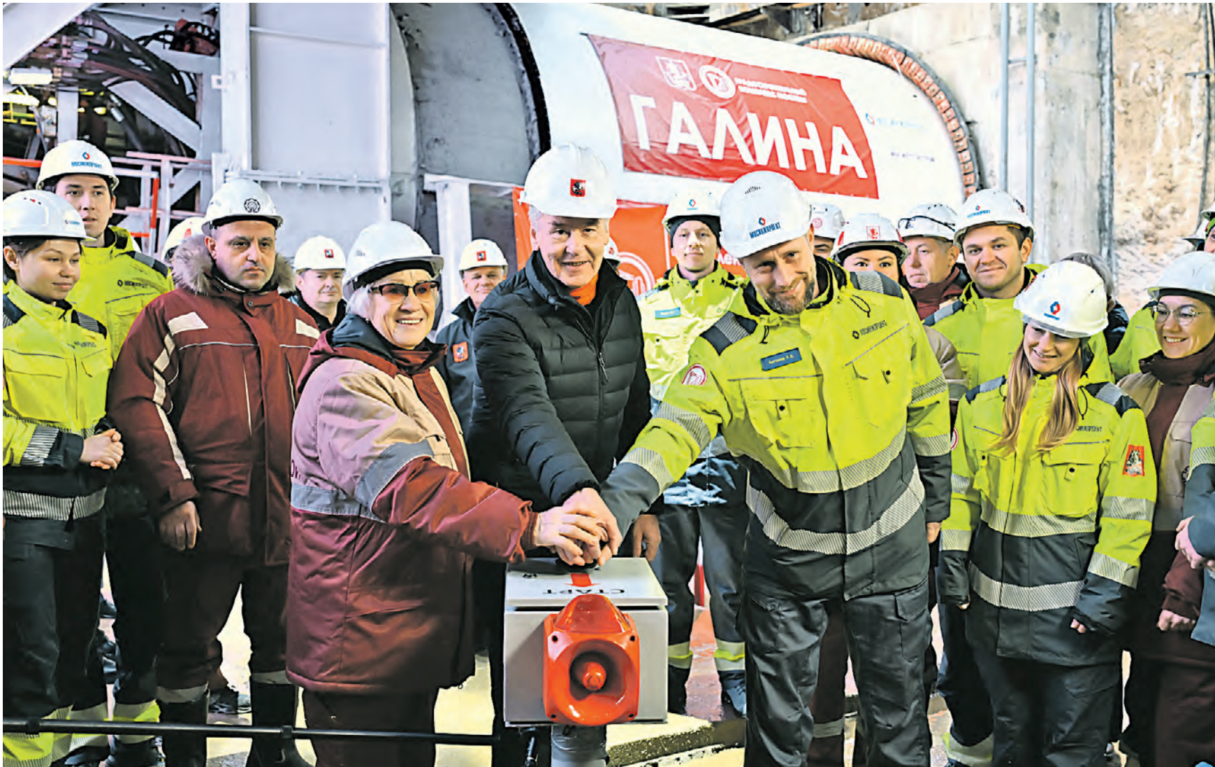
1 ноября. Мэр Москвы Сергей Собянин (в центре на первом плане) дал старт строительству метротоннеля от «Щелковской» до «Гольяново»
